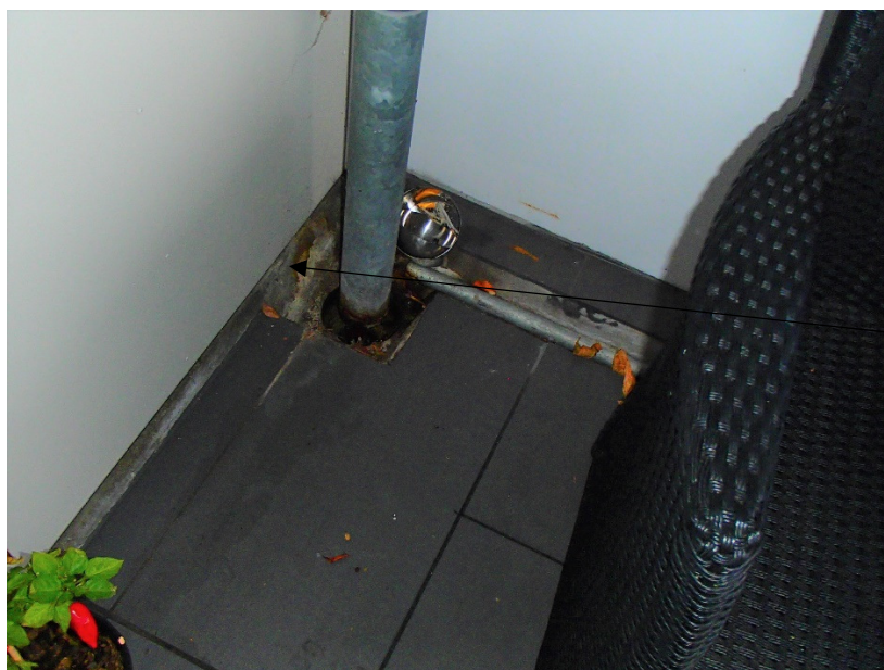
Membran under beklædning
