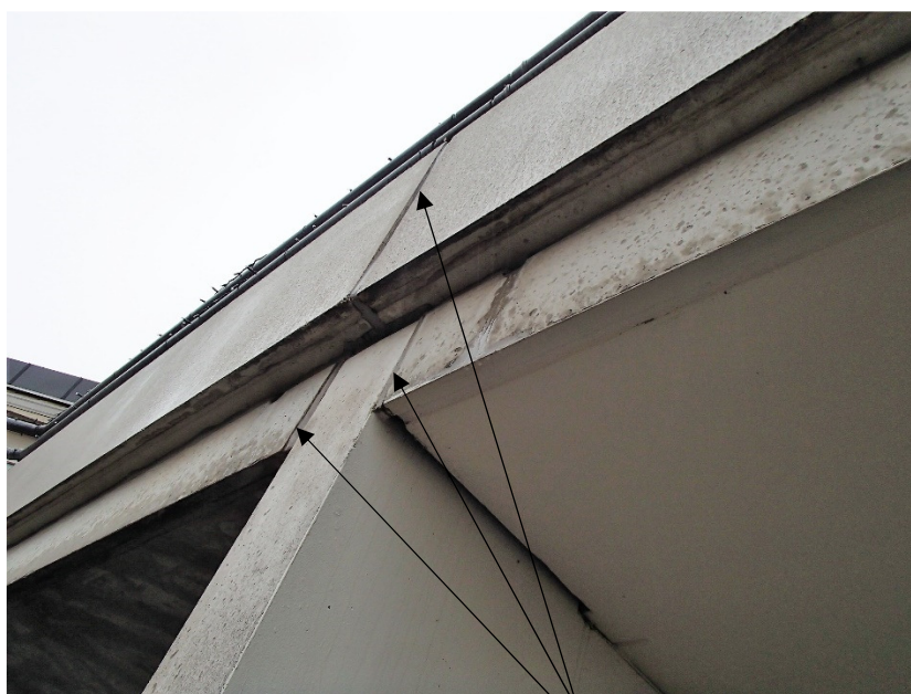
Udvendige fuger i facade
