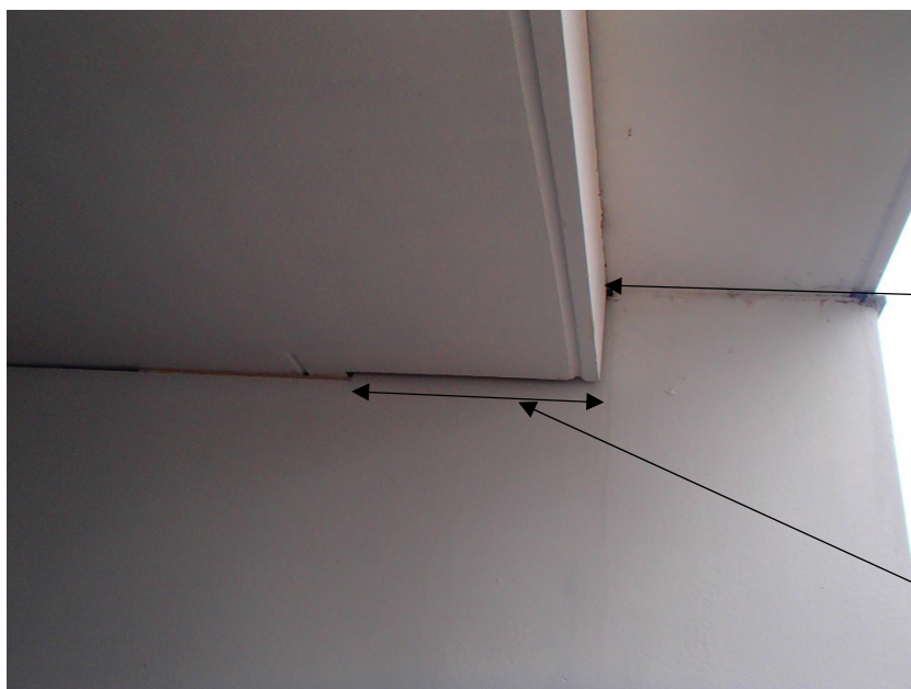
Aftegning af vand på altanskillevæg
