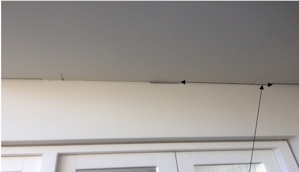
Eksempel på bæreflade på betonramme i lejlighed på 2sal.
